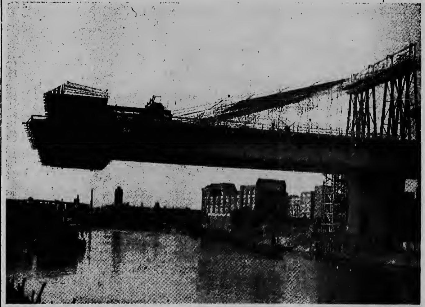
Nan ta trahando un brug actualmente na Berlin cu ora e ta cla lo tin 875 meter largu. Cu construccion dje brug aki di 29 meter hanchu nan a cuminsa na principio di anja y nan ta spera cu e trabao lo bini cla aki cator anja.
